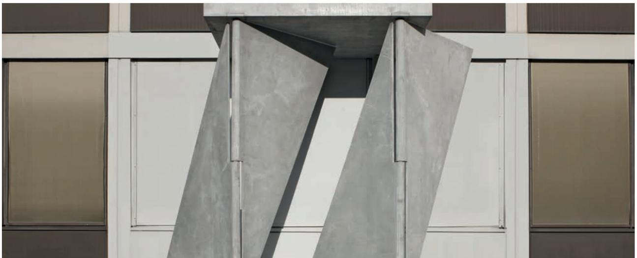
Das Projekt „Sun Sails“ der Hochschule Trier erprobte den Einsatz von Textilbeton für filigrane Fassadenbauteile
