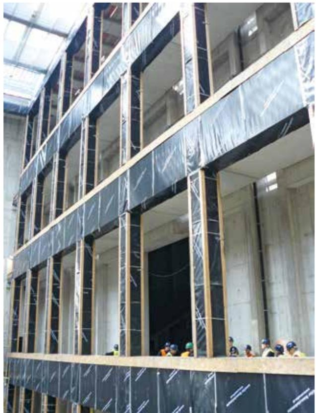
Schutzverpackung für hochwertige Betonfertigteile: In diesen hohen Galerien der mit schützender Verpackung ummantelten großformatigen Betonfertigteile muten Baustellenpersonal oder Besucherguppen fast wie kleine Insekten an
