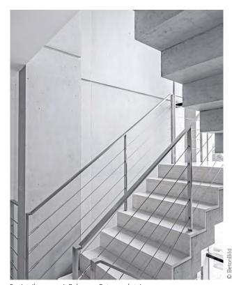
Fertigteiltreppe mit Belag aus Betonwerkstein.
