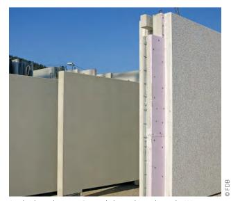
Sandwichwand mit zwei Betonschalen und innenliegender Wärmedämmung.
